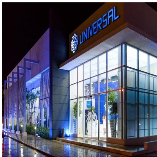
Edificio Universal Zona Oriental
