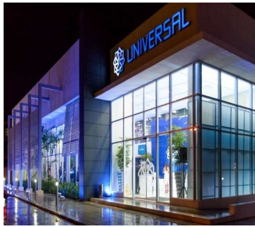
Edificio Universal Zona Oriental
